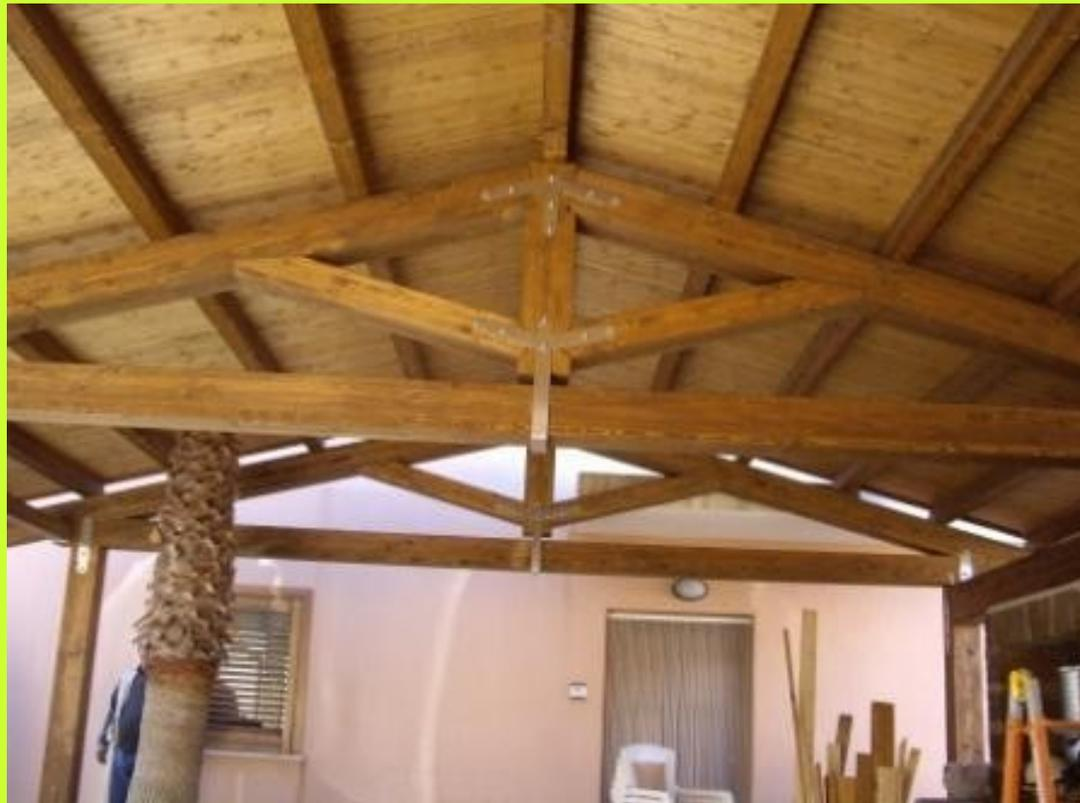
**In Italia, quindi, il legno nelle costruzioni significa elemento per resistere agli sforzi di flessione (la trave), significa capriata per la coperture e soprattutto infissi di porte e finestre.**
