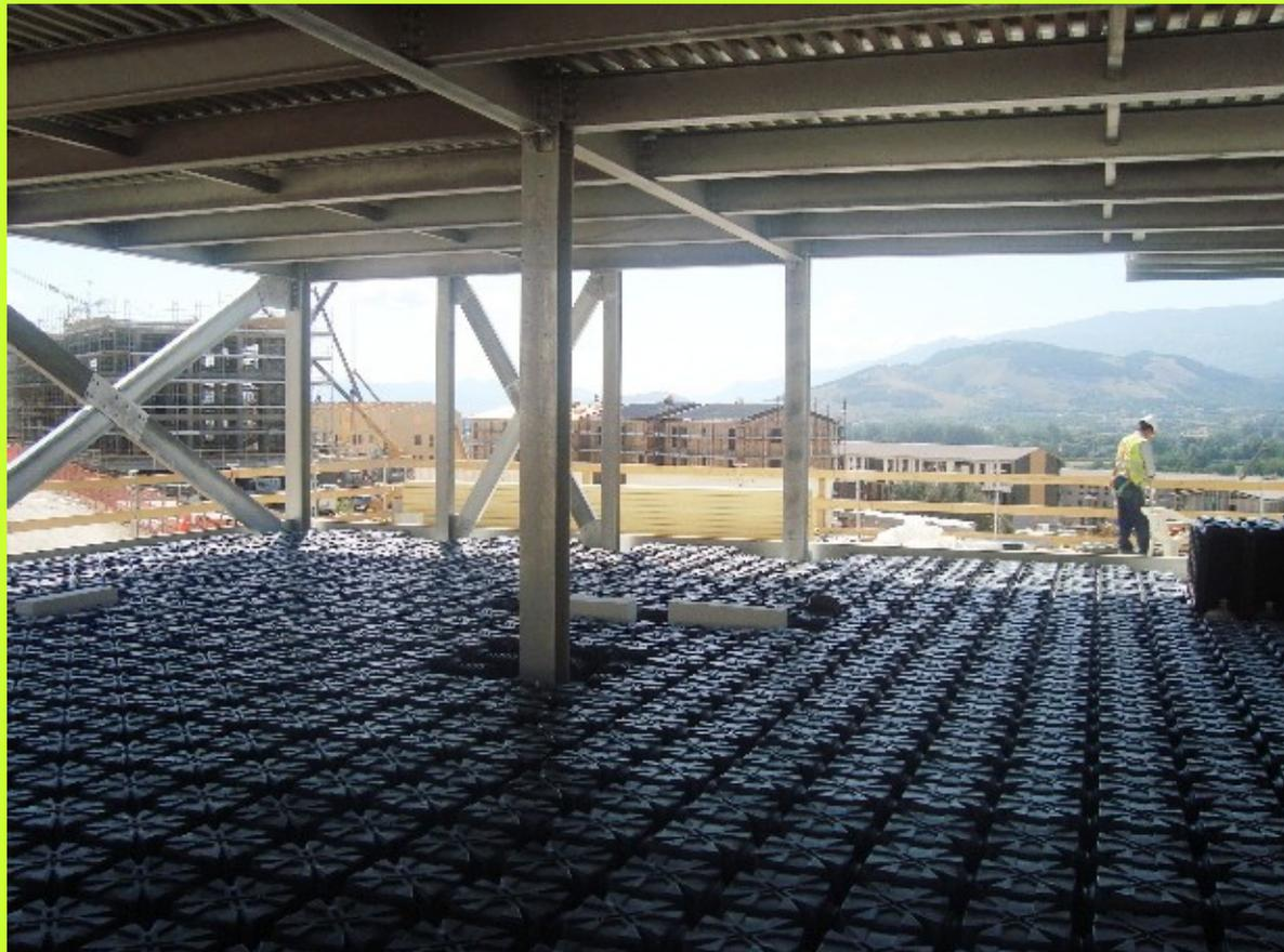
La sicurezza antisismica è assicurata da una sottostruttura di fondazione e da dispositivi di isolamento a elevata deformabilità con una sovrastruttura libera di muoversi nel piano.
